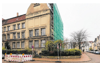
Der Standort am Marquardplatz wird ab 2019 saniert. FOTOS: ROESSLER
